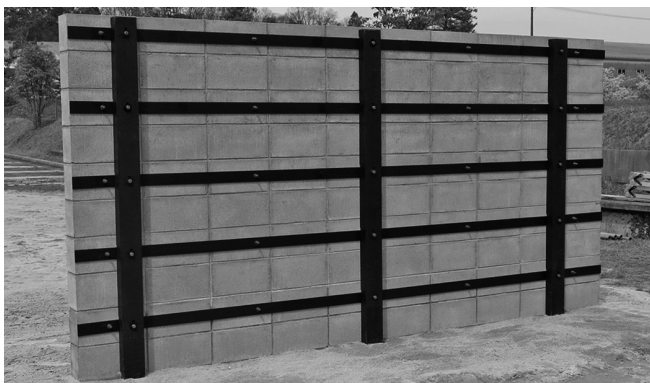
取付完了(敷地側)
